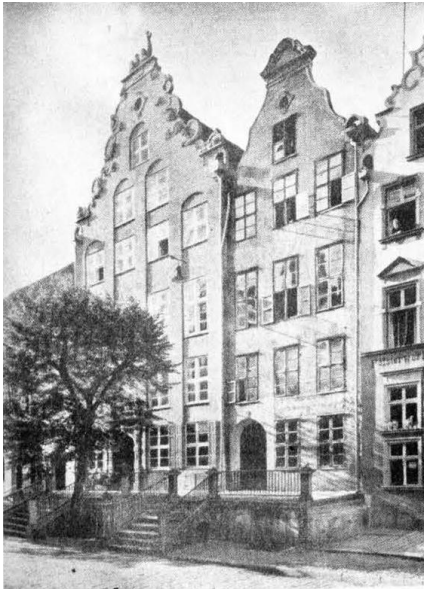
Barocke Giebelhäuser mit Beischlägen in der Spieringstraße.
